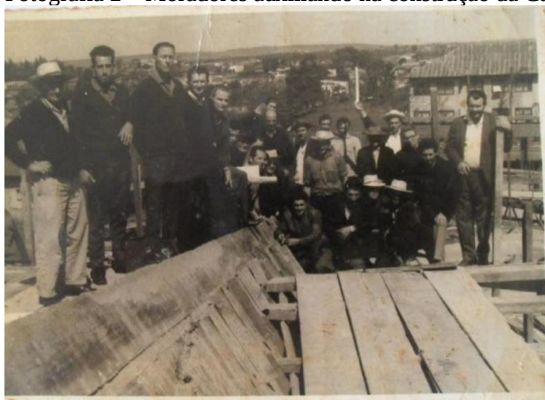
Fotografia 2 – Moradores auxiliando na construção da Catedral
